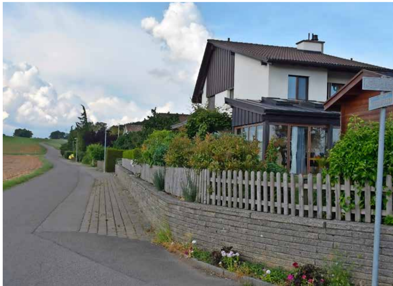
Nachdem die Sanierung der Birchstrasse in Stetten von der Einmündung Bühlstrasse bis zur Lohnemerstrasse immer wieder verschoben wurde, sollen nach den Sommerferien die Bauarbeiten beginnen.
